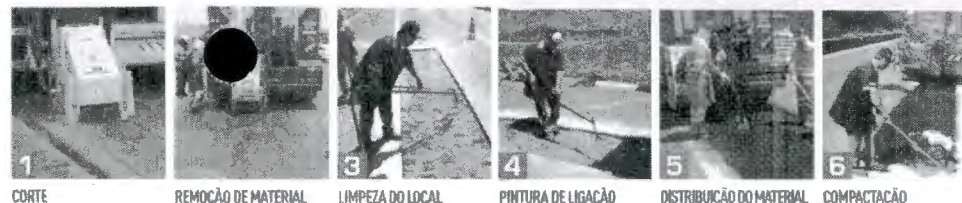
1 CORTE 2 REMOÇÃO DE MATERIAL 3 LIMPEZA DO LOCAL 4 PINTURA DE LIGAÇÃO 5 DISTRIBUIÇÃO DO MATERIAL 6 COMPACTAÇÃO
